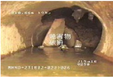
破損した管路
