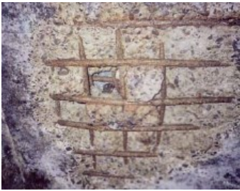
腐食による鉄筋の露出
