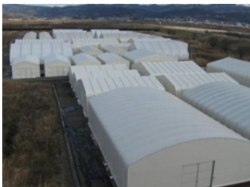
下水汚泥の保管状況（福島県ホームページから引用）
