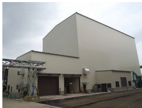
仮設焼却施設（同左）
