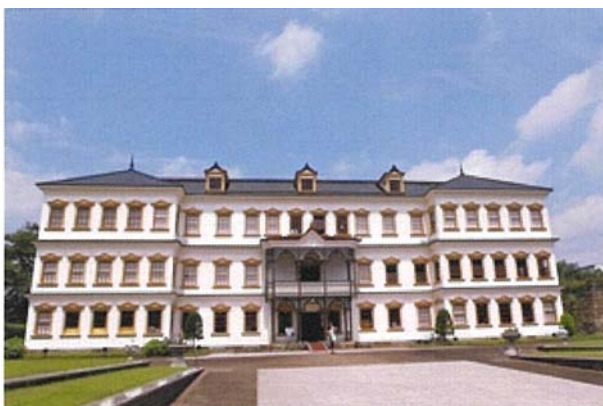
移転後の小坂鉱山事務所
