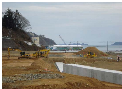
プレキャストボックスの施工状況
