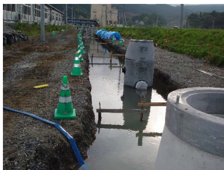
満潮時の下水施工状況
