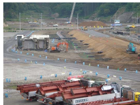
暗渠排水施工状況
