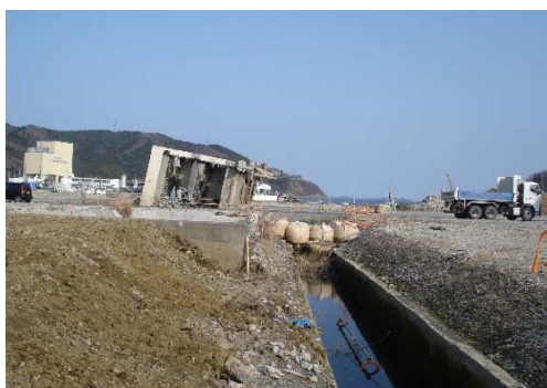
女川湾付近の既設水路状況（2013. 5）
