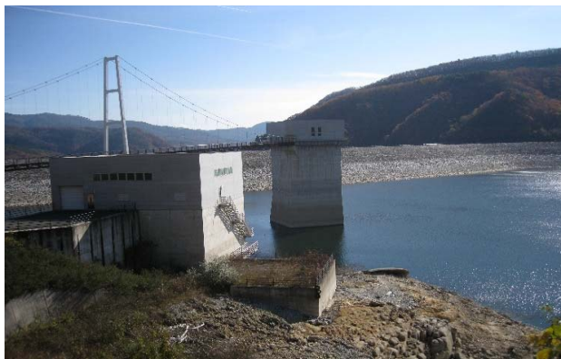
ダム堤体全景（上流側より） 中央が取水塔
