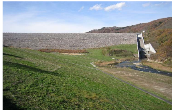
ダム堤体全景（下流側より） 右端が洪水吐
