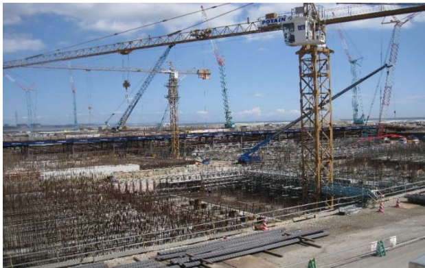
復旧工事が順調に進む現場
