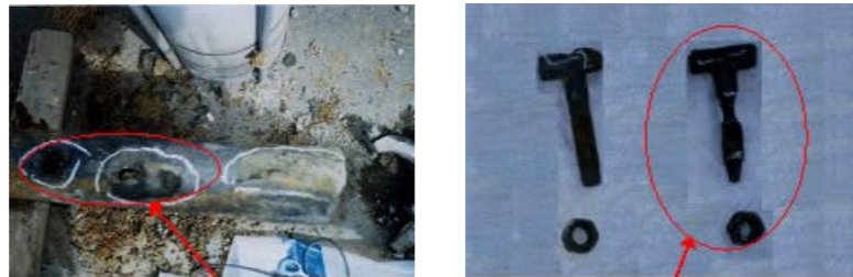
写-1. 初期ダクタイル管の腐食 出典：東京都水道局HP
